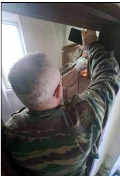
Kirkon sähköistykseen valmistelutyöt, kuvassa on Mihail Kovalev.
